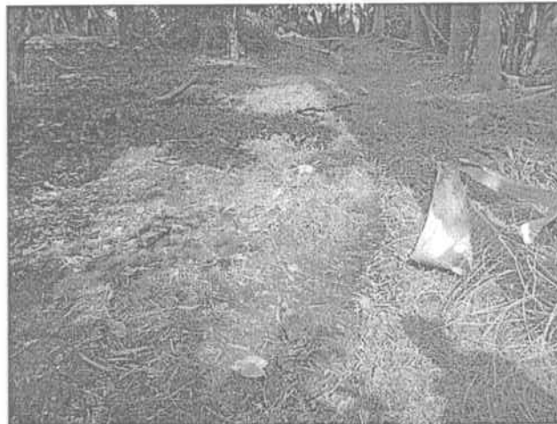
Foto 4. Tomada el día 29 de agosto de 2017. Canal por donde fluye agua lluvia. Se está adecuando el terreno para evitar futuros empozamientos de agua lluvia.
